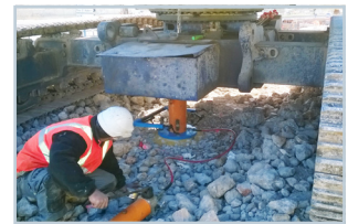
Essai de chargement
