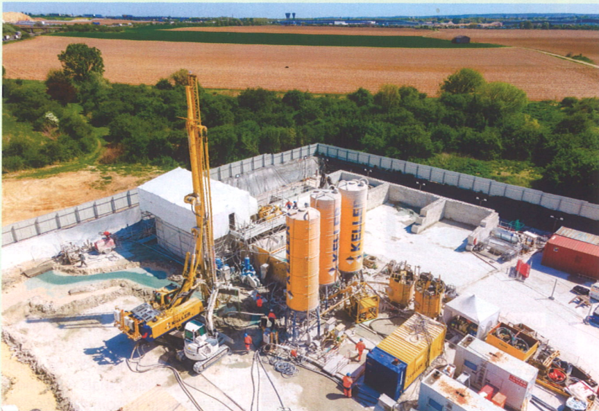
Vue globale du chantier.
