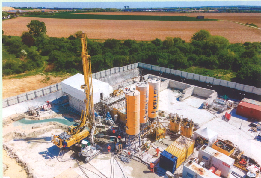
Vue globale du chantier.
