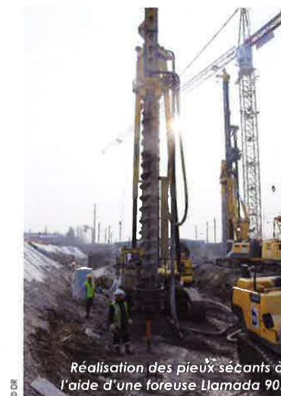
Réalisation des pieux sécants à l'aide d'une foreuse Llamada 90.
