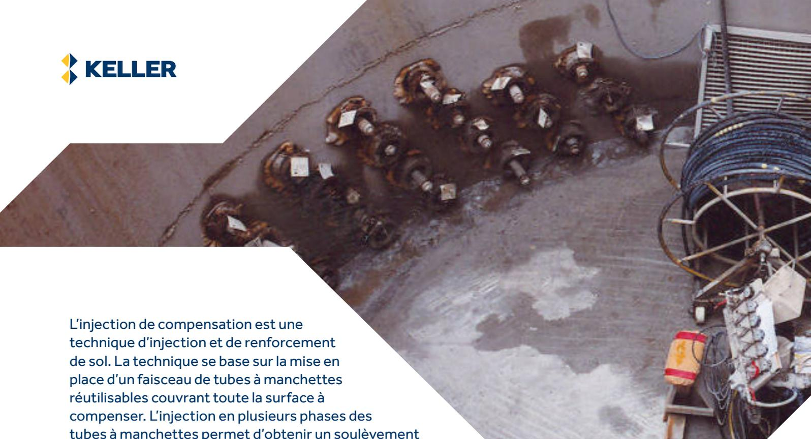
L'injection de compensation est une technique d'injection et de renforcement de sol. La technique se base sur la mise en place d'un faisceau de tubes à manchettes réutilisables couvrant toute la surface à compenser. L'injection en plusieurs phases des tubes à manchettes permet d'obtenir un soulèvement contrôlé de compensation des tassements des structures en surface.
