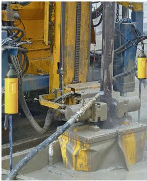
L'installation de l'ACI® pour déterminer le diamètre des colonnes
