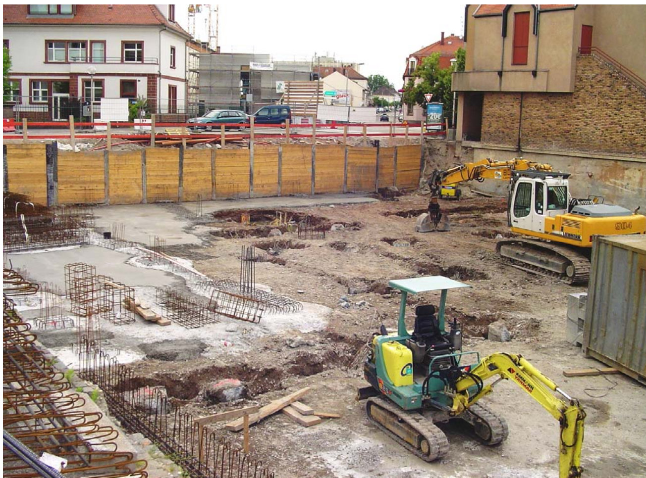
▲ Vue d'ensemble du chantier
