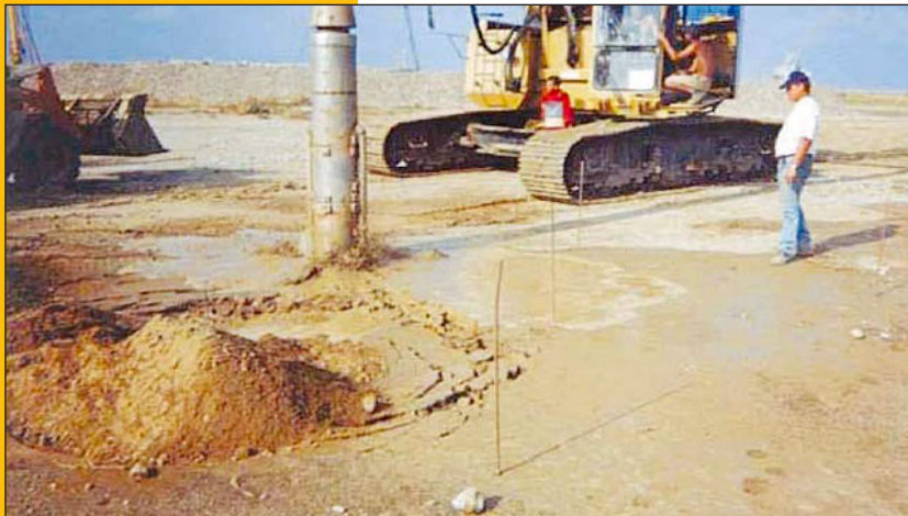
▲ Planche d'essai du vibrocompactage
