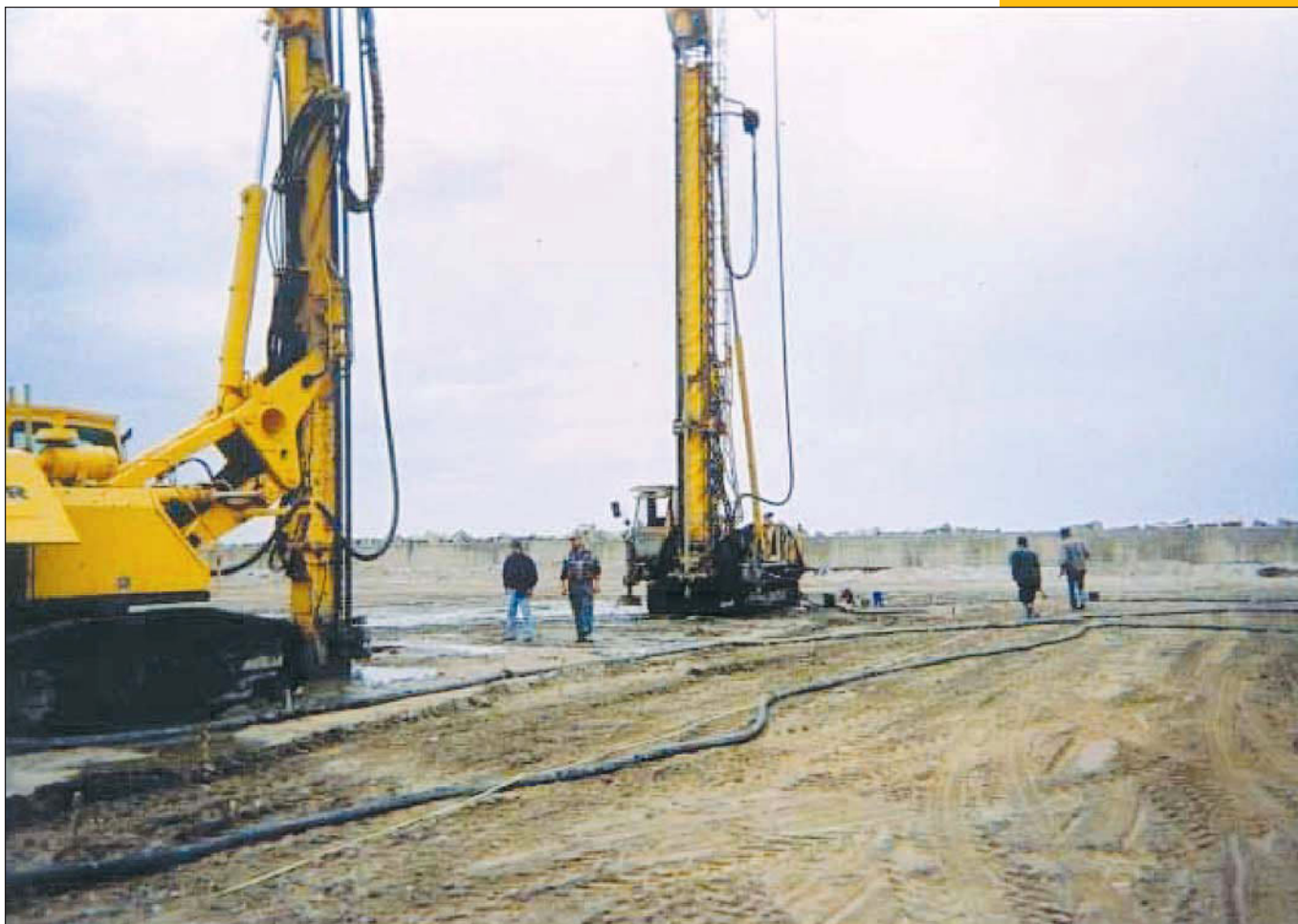
▼ Exécution des forages et de l'injection en simultané
