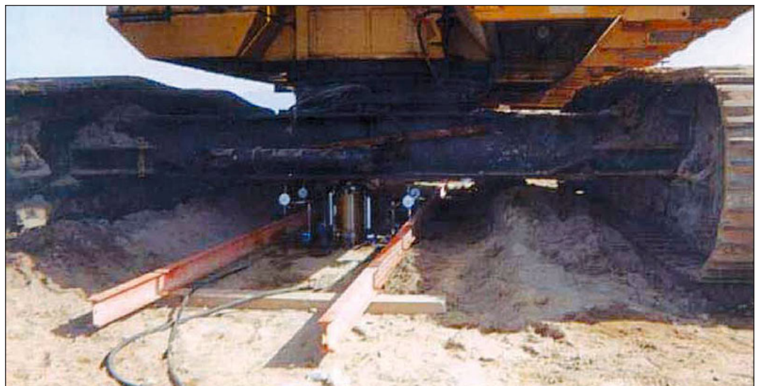
Essai de chargement ► sur une colonne ballastée
