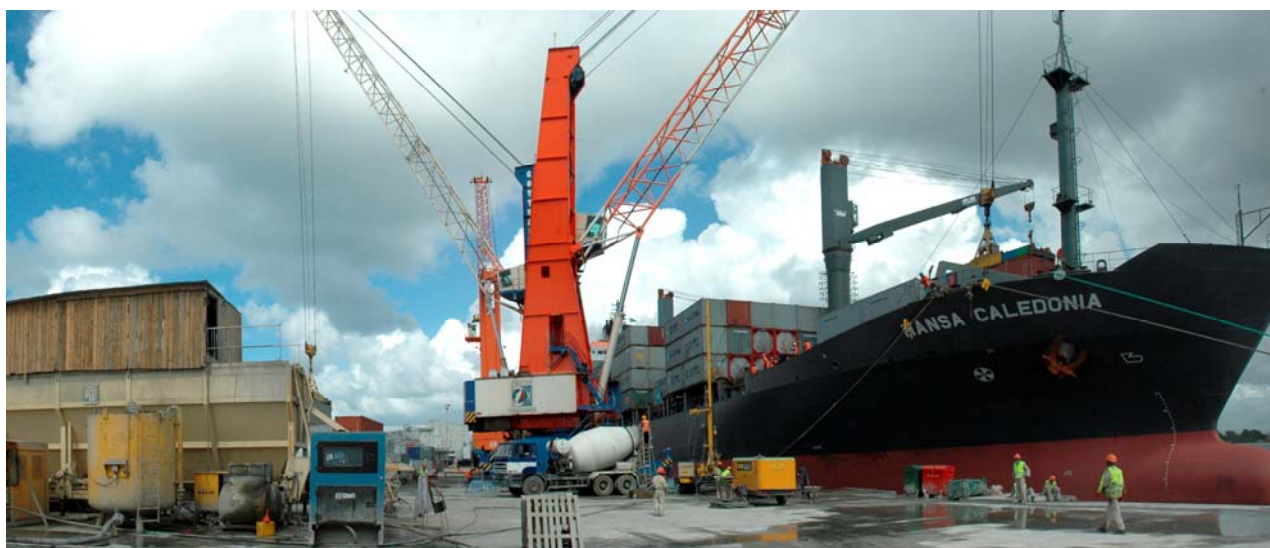
▲ Vue d'ensemble du chantier
