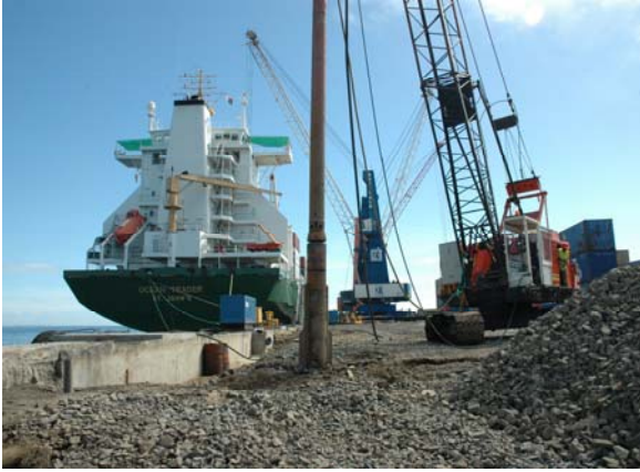
▲ Réalisation des colonnes ballastées sur le quai C2
