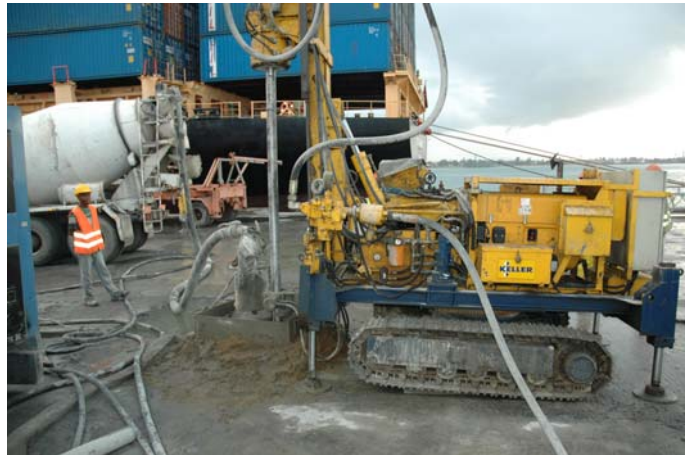
▲ Réalisation des colonnes de jet grouting
