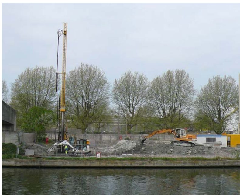
▲ Vue générale du chantier côté puits de départ
