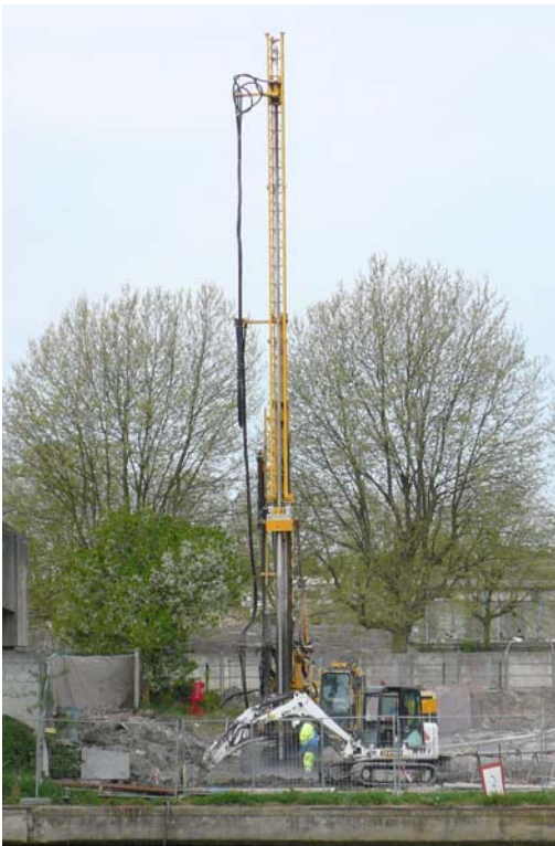
▲ Foreuse KB 2 côté puits de départ
