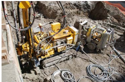
▲ Foreuse KBO pendant la réalisation du jet grouting
