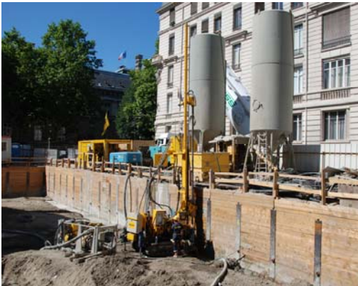
▲ Paroi berlinoise et jet grouting en bordure des rues Molière et Bonnel
