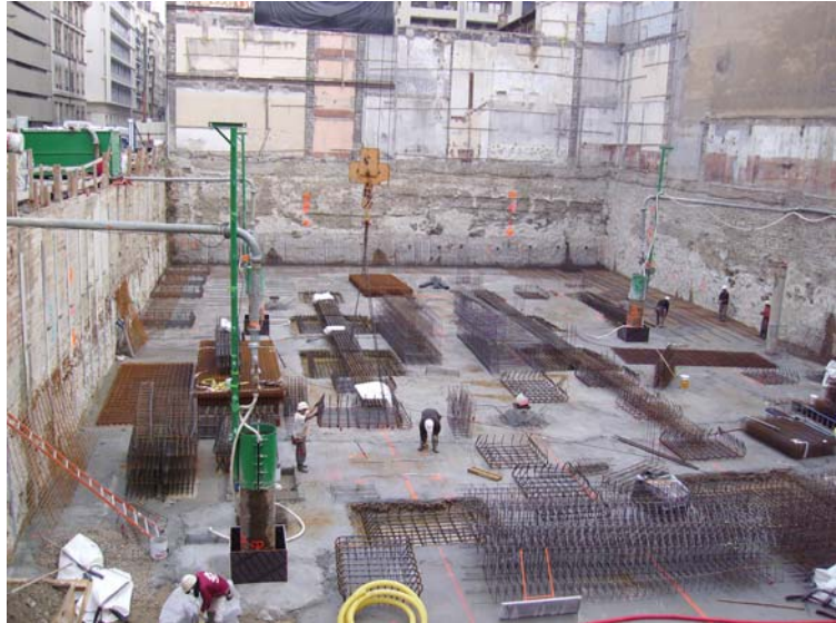
▲ Vue de la fouille après terrassement et début des travaux de gros-œuvre
