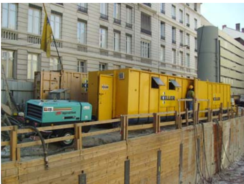
▲ Conteneurs d'injection pour la réalisation du bouchon injecté
