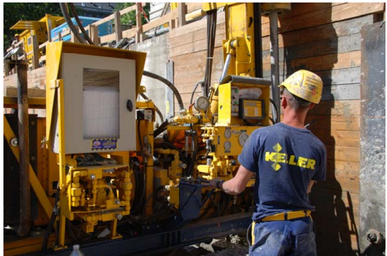
▲ Enregistrements et contrôle des paramètres de jet grouting
